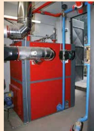
Caldaia centralina a biomassa.
