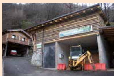
Locale centralina a biomassa.
